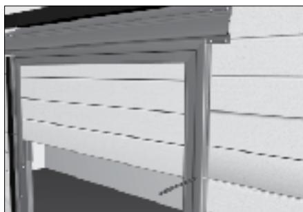
Установите на верхний сегмент калитки верхний горизонтальный Ц-профиль и боковые Ц- и П-профили. По месту отмерьте их длину, ориентируясь по середине стыков панелей, и отрежьте с помощью ножовки по металлу.
