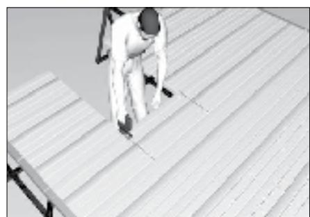
Поочередно в каждой панели вырежьте внешний контур калитки с помощью электролобзика.
