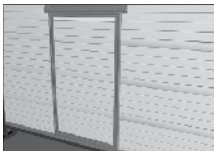
Выровняйте по линейке все профили на полотне калитки и закрепите с помощью заклепок.
