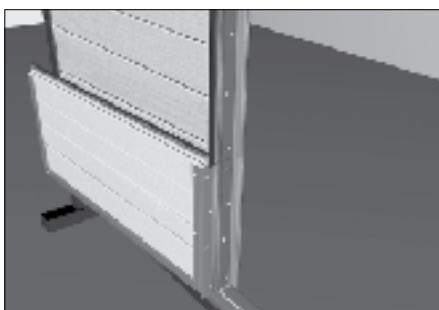
Снимите все сегменты калитки кроме нижнего. Приставьте нижний сегмент калитки к раскрытым петлям и закрепите их с помощью заклепок, соблюдая боковой зазор 2 мм.
